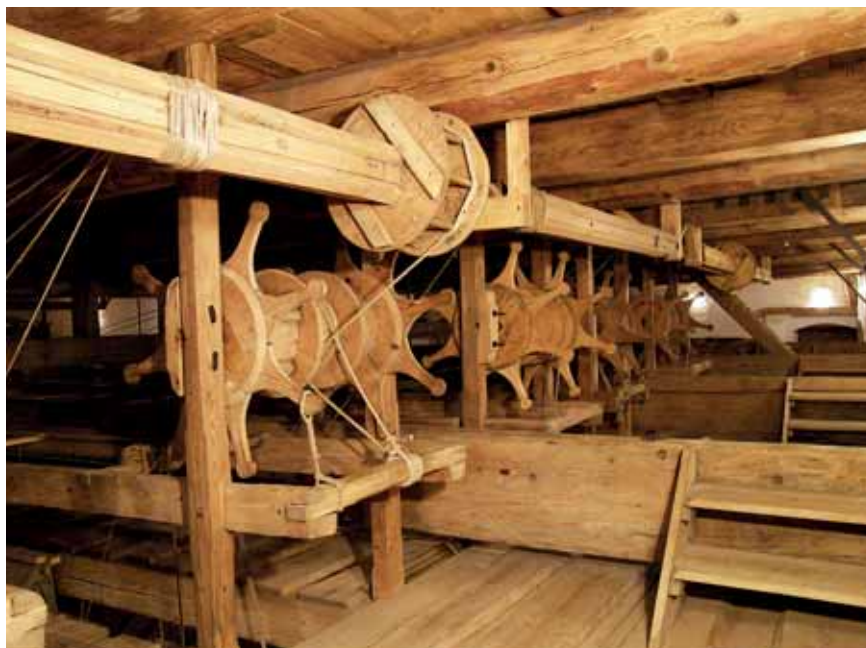
Český Krumlov, zámecké divadlo. Jevištní mašinerie v provazíšti nad jevištěm.
